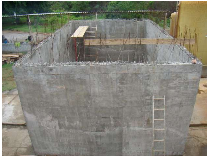
Figura 9: Construção de um reservatório.
