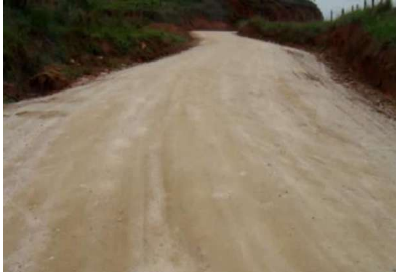
Figura 5: Estrada de Ubari conservada.
