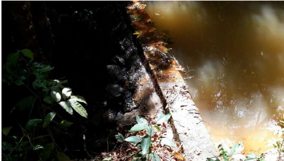
Figura 7: Barragem feita de concreto, impedindo o curso d'água.
