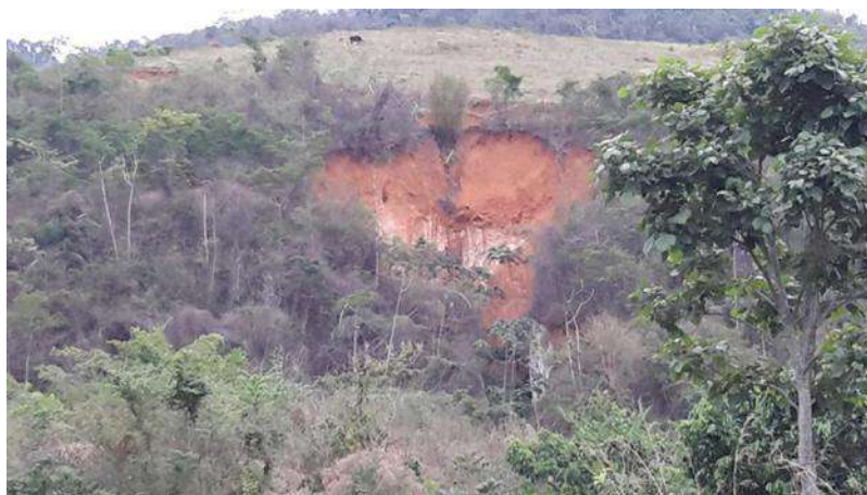
Figura 5: Erosão próxima à "Caixa D'água".
