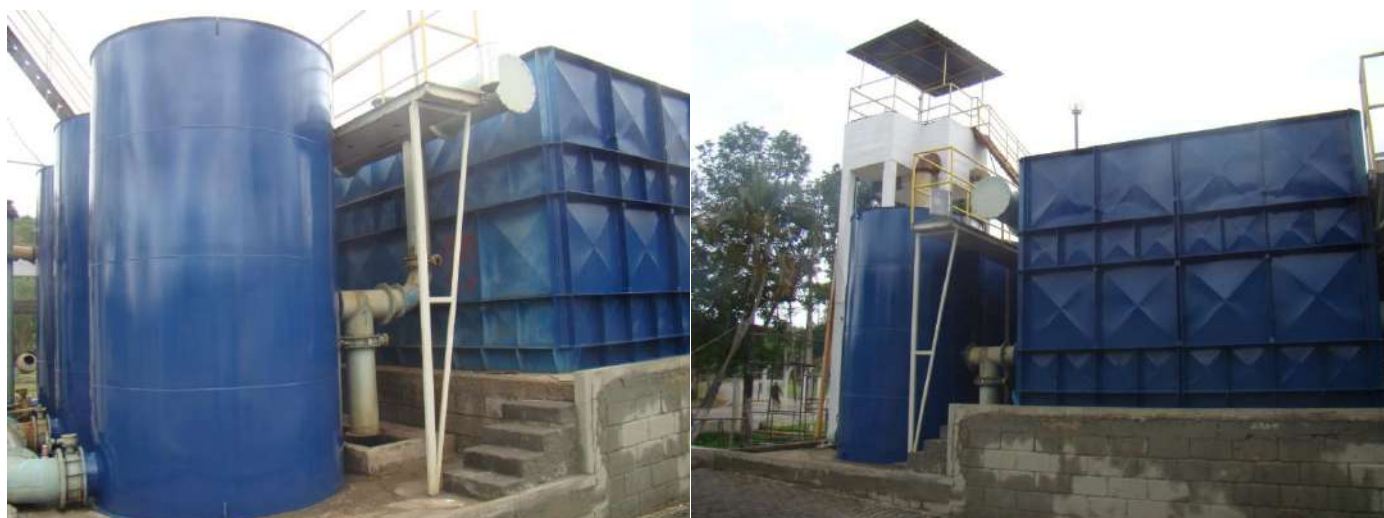
Figura 4: Decantador, elevatório e filtros com a estrutura reformada e em processo de reforma.
