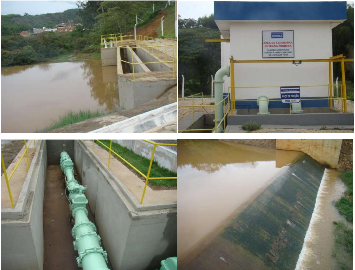
Figura 1: Atual posto de captação de água superficial - Miragaia.
